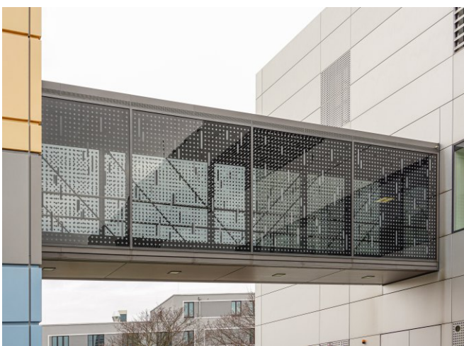
TU Dresden Werner-Hartmann-Bau, Markierter Glasverbinder
