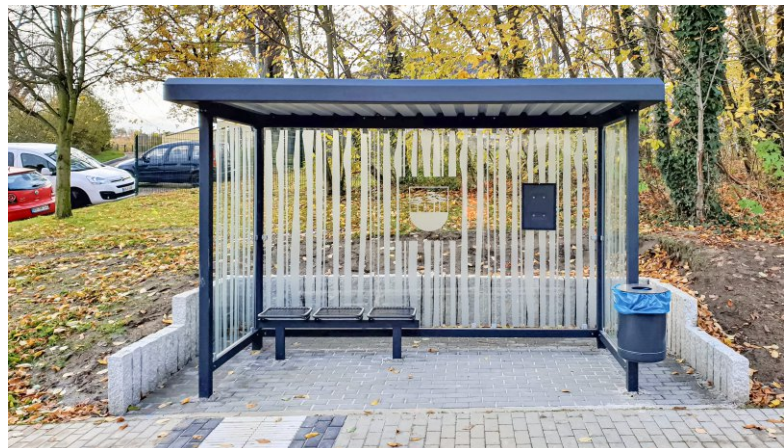
Neu aufgestellte Warthäuschen der Gemeinde Ottendorf-Okrilla werden bereits werkseitig mit Folien-Digitaldruck versehen. © Daniel Großmann
